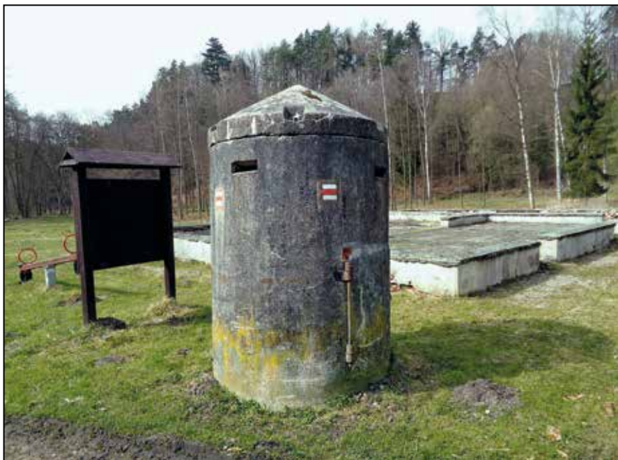
Rabštejnské údolí – protiletectký bunkr a základy bývalé strážnice. Archiv autora
